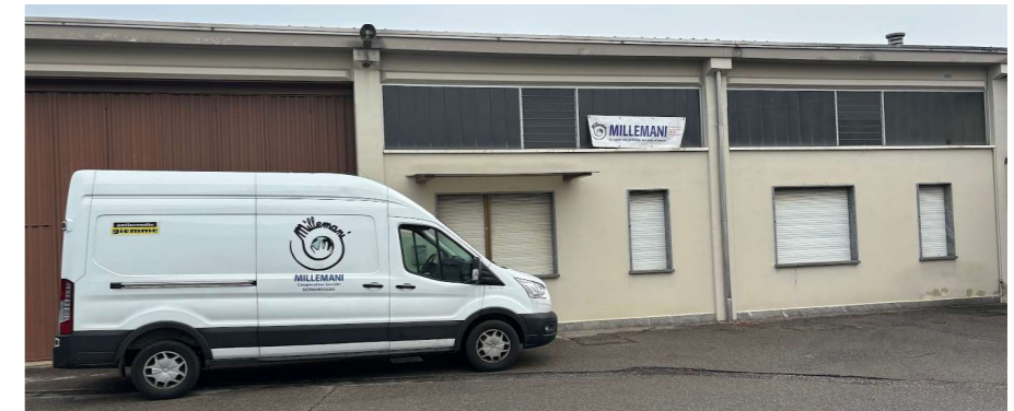
Il capannone di via Dell'Artigianato, futura sede della Cooperativa
